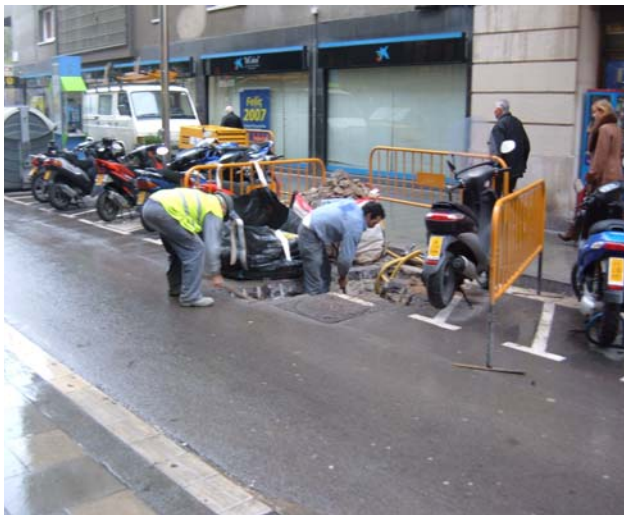
FOTO 3 Vista general de la realització de la rasa 2
