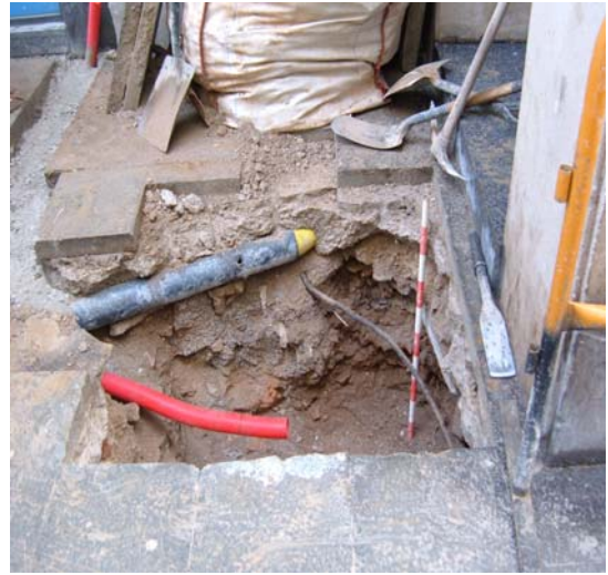
FOTO 6 Detall del forat de la arqueta 1, on s'aprecien els serveis existents
