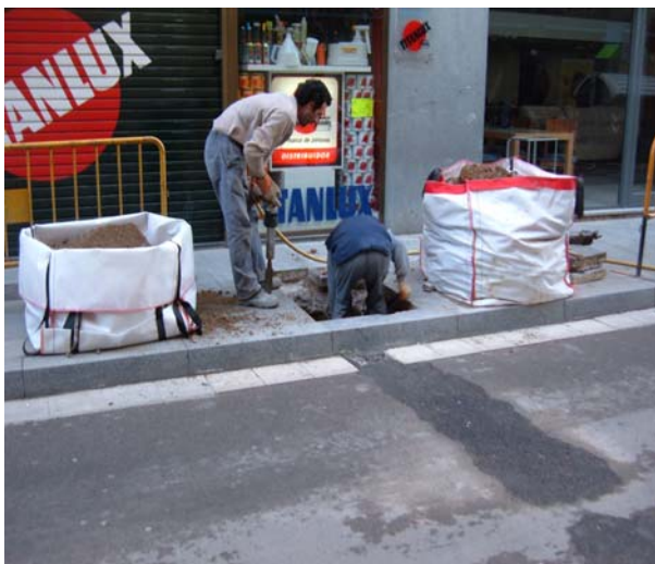
FOTO 7 En primer terme, la rasa 2 ja tapada, i a continuació, realització del forat de la arqueta 2
