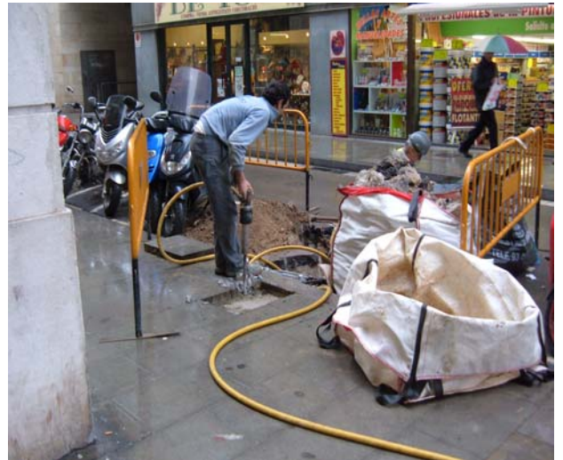
FOTO 2 Realització de la rasa 1
